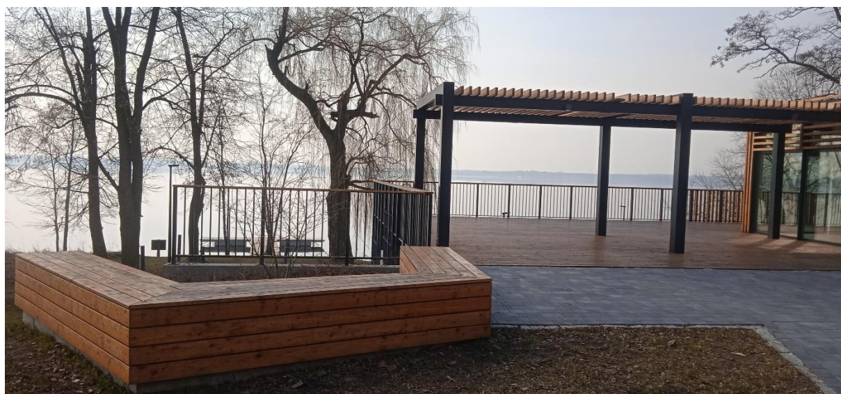
Fot 8. Budynek usługowy w Zegrzu
