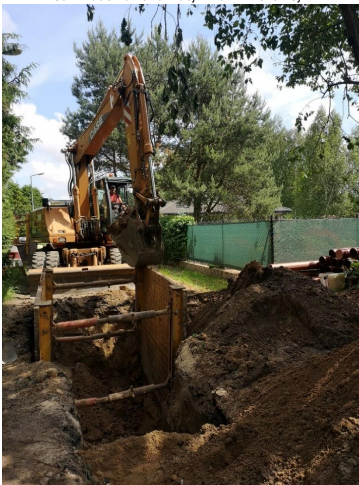
Fot 1. Budowa kanalizacji w ul. Brzozowej
