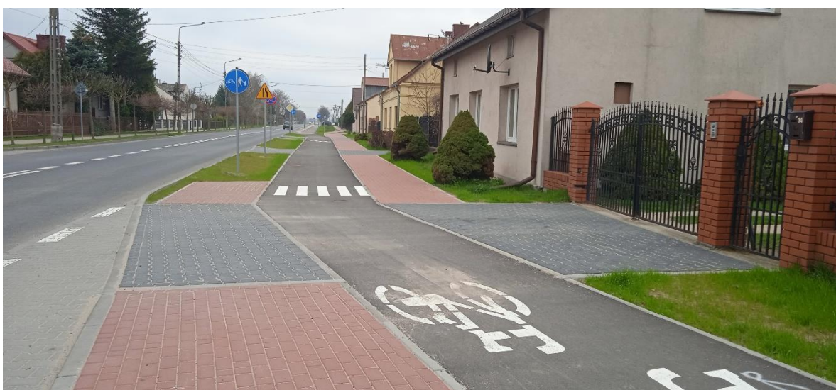
Fot 2. Ścieżka pieszo-rowerowa przy ul. Zakroczymskiej
