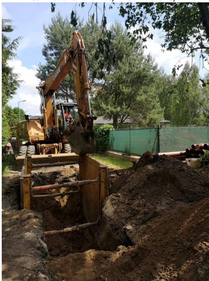
Fot 1. Budowa kanalizacji w ul. Brzozowej
